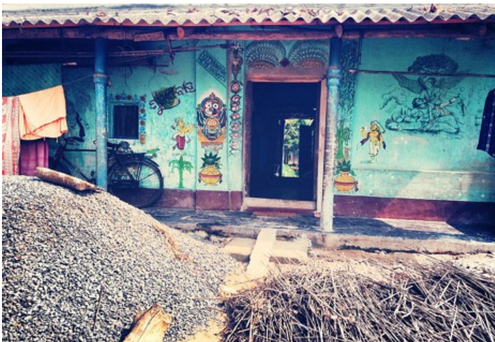
Figura 2, Villaggio di Raghurajpur: parete d'ingresso di un'abitazione locale.
